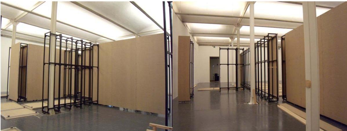
**2a fase: Panelado de las estructuras con panel de aglomerado ignifugo**
